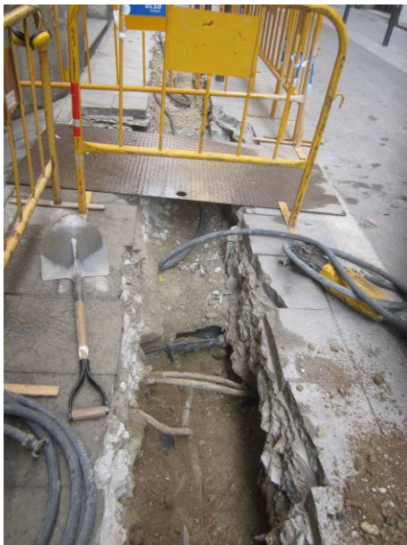
7. Serveis actuals a l'alçada del c/Trinitat.
