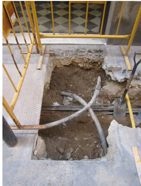
12. Sondeig inicial a la porta d'accés de la finca núm. 6.
