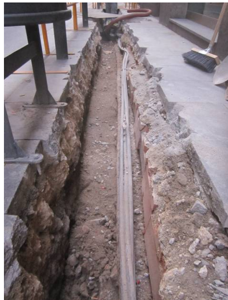
8. Cablejat elèctric davant la finca núm. 6.
