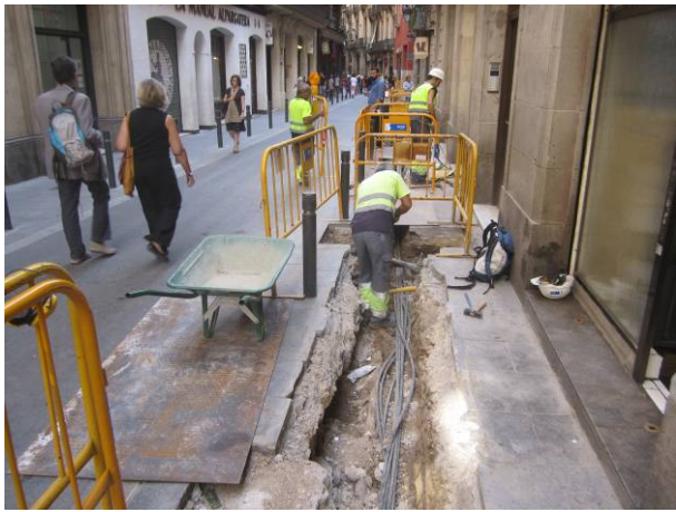
13. Vista general de la rasa.
