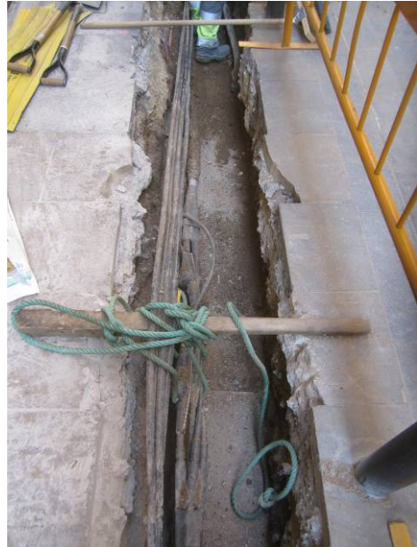
10. Cablejat elèctric davant la finca núm. 6.
